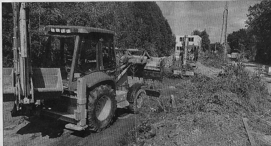
À L'ENTRÉE DE LA VILLE. Les travaux ont débuté, le site devrait accueillir à terme un local commercial et des entreprises. Selon Isabelle Briquet, la dépollution des lieux a bien été menée selon les règles. PHOTO STÉPHANE LEFEVRE
